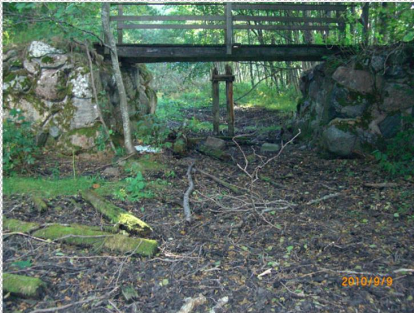
Foto 1 Landfästen till äldre bro, vy från öster (Foto Per Vallander, Sweco)
